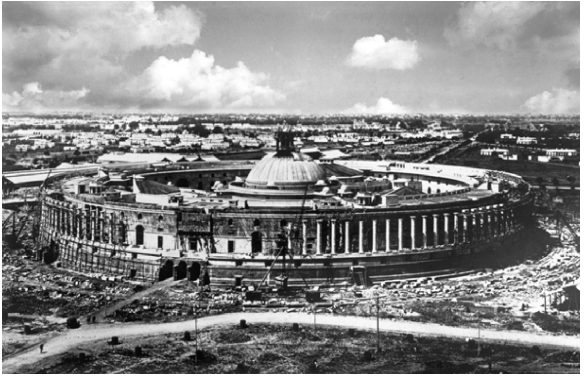
^ निर्माणाधीन संसद भवन
